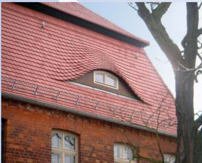
Ziegeldeckung mit Biberschwanzdoppeldeckung
