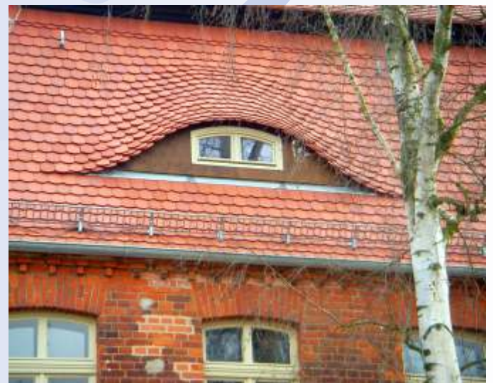
Ziegeldeckung mit Biberschwanzdoppeldeckung
