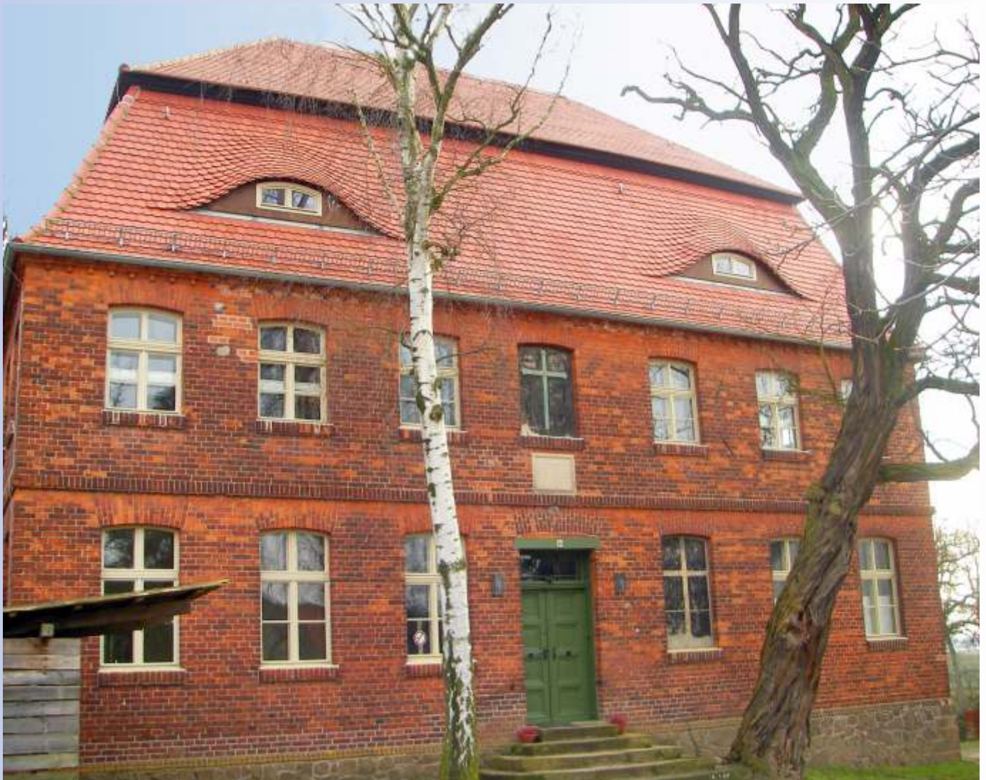
Ziegeldeckung mit Biberschwanzdoppeldeckung
