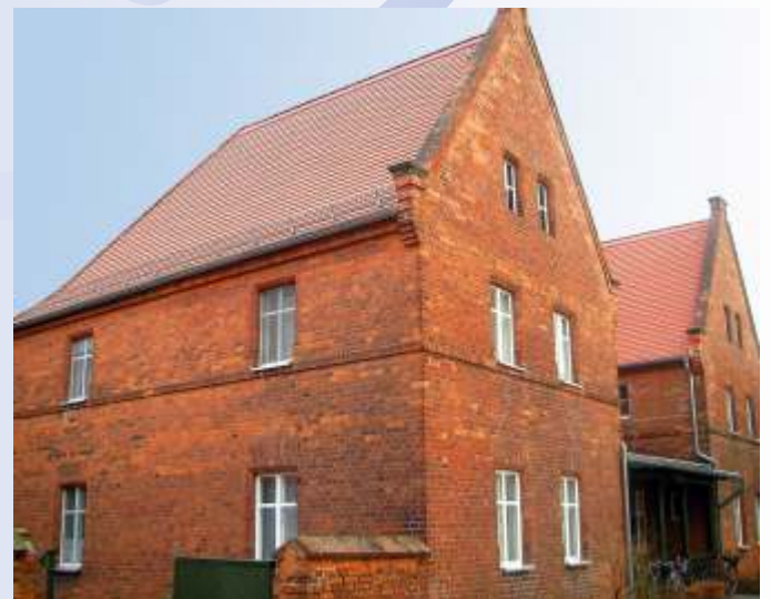
Ziegeldeckung mit Biberschwanzdoppeldeckung
