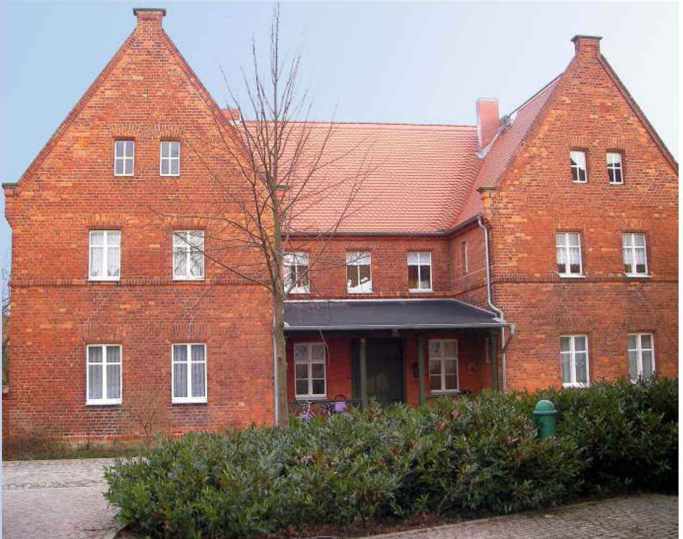
Ziegeldeckung mit Biberschwanzdoppeldeckung
