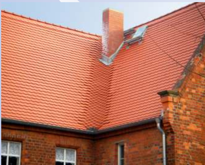
Ziegeldeckung mit Biberschwanzdoppeldeckung
