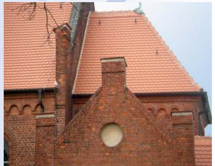
Ziegeldeckung mit Biberschwanzdoppeldeckung
