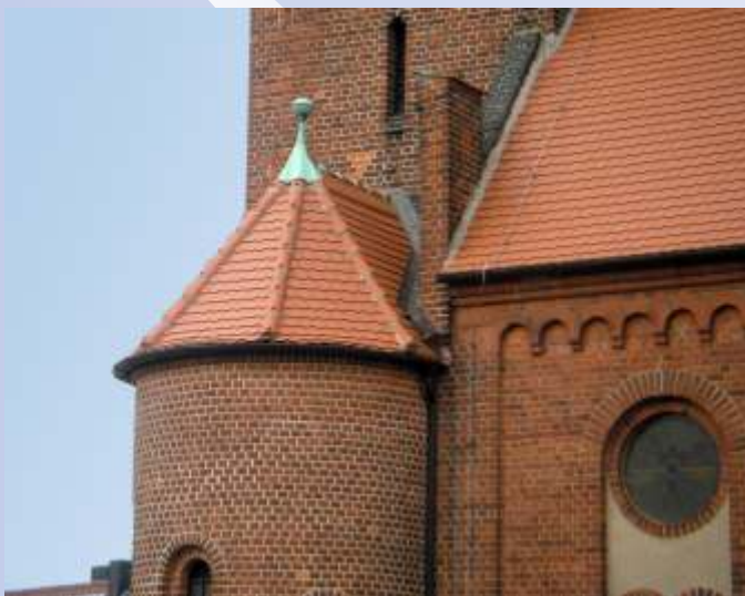
Ziegeldeckung mit Biberschwanzdoppeldeckung
