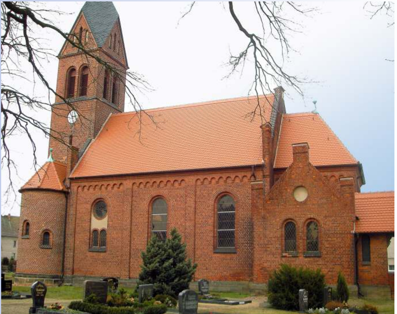
Ziegeldeckung mit Biberschwanzdoppeldeckung
