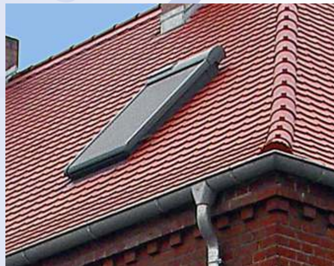
Ziegeldeckung mit Biberschwanzdoppeldeckung
