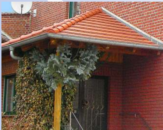
Ziegeldeckung mit Biberschwanzdoppeldeckung
